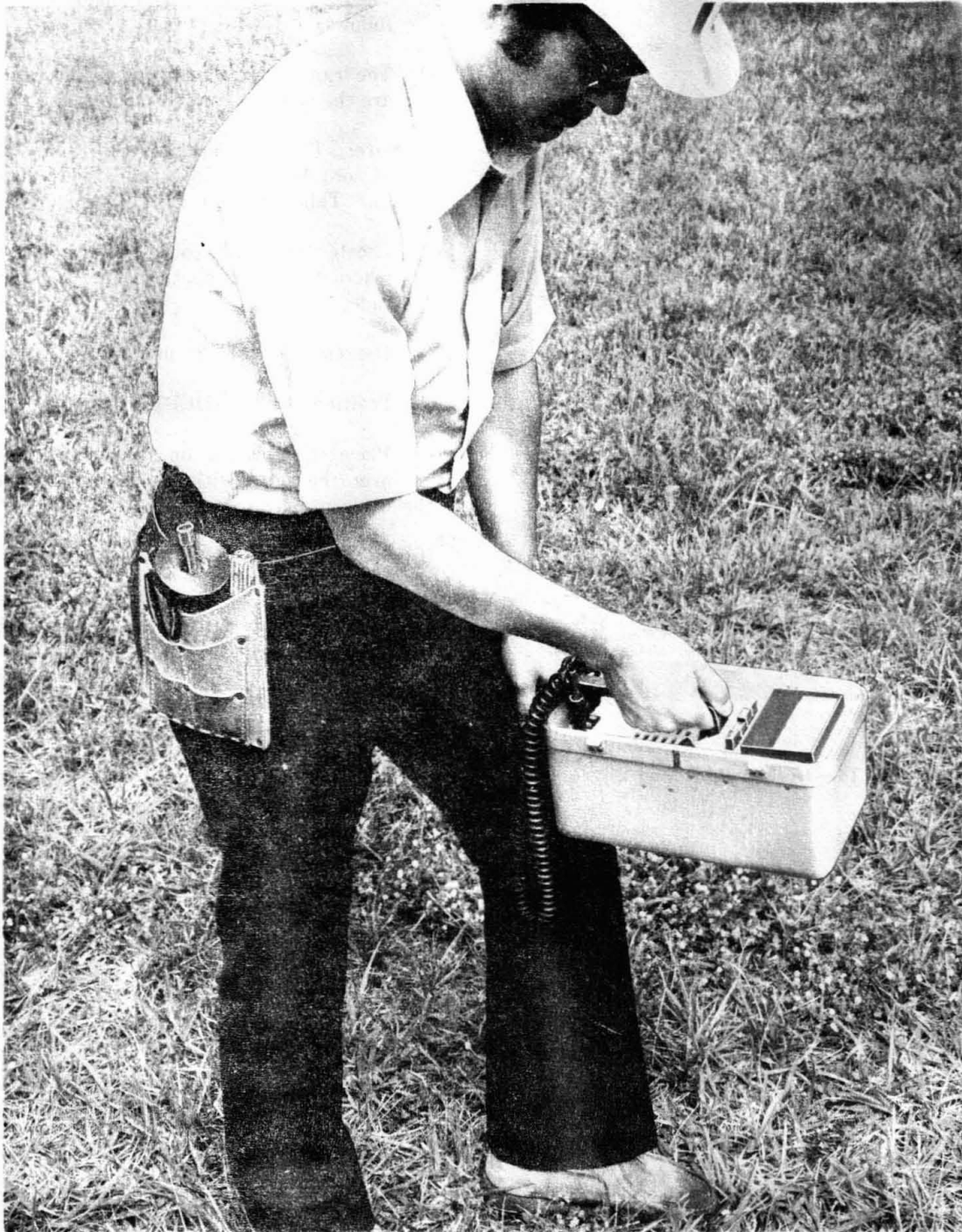
Fig. 15—Measuring Cable Depth
