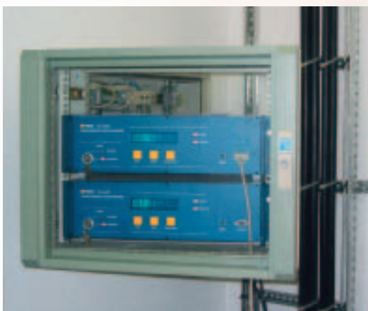
Bild 2: LSV-6200 Controller für Rotations- und Translationsgeschwindigkeit im E-Raum
