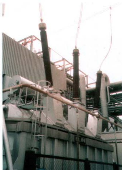
Bild 6. Faseroptische Temperaturmessung an der Stromdurchführung eines Transformators
